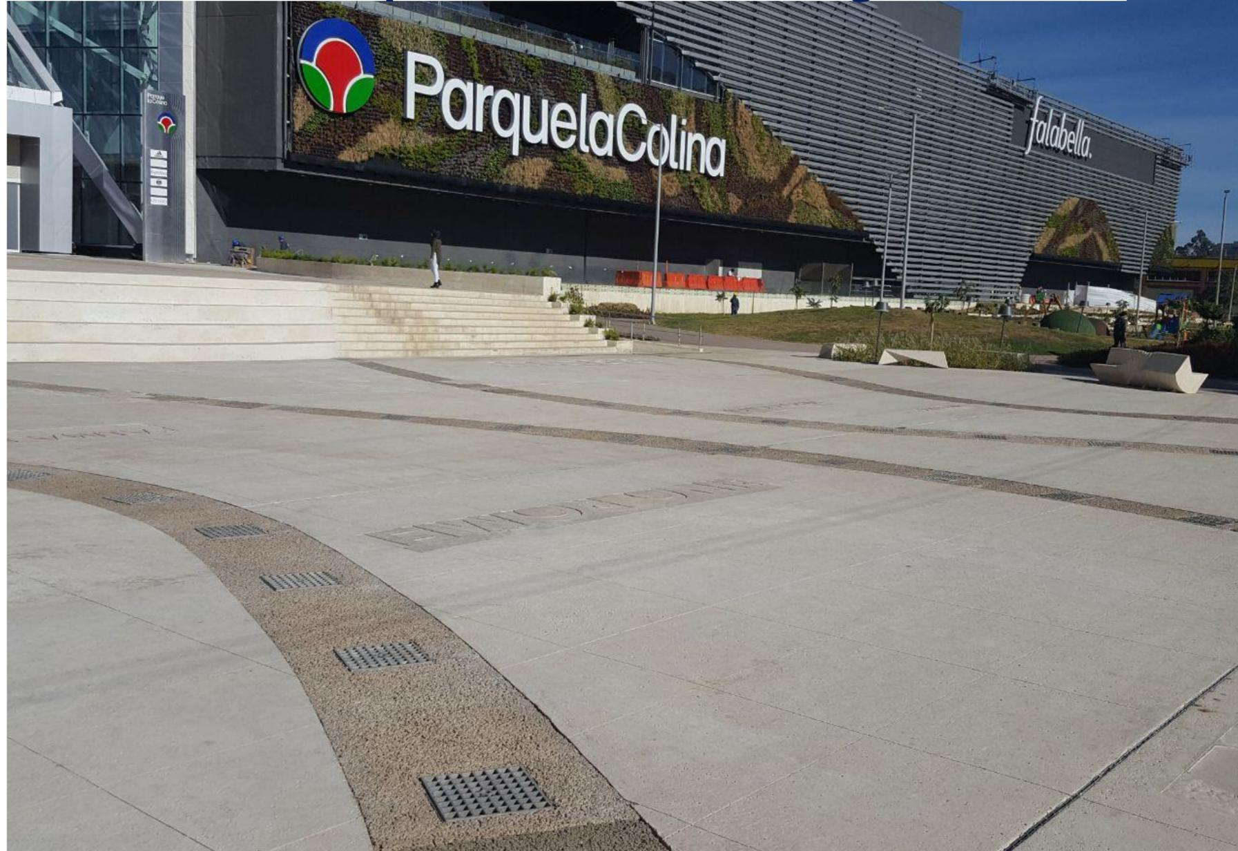
□ Filtración de agua lluvia para recirculación en fuentes de agua
